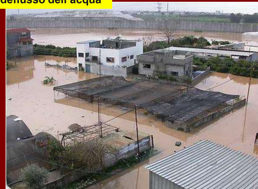
Il muro impedisce il deflusso dell'acqua
