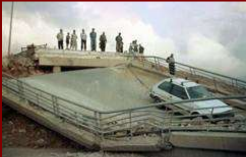
Ponte a Sidone distrutto dagli israeliani il 25 giugno 1999
