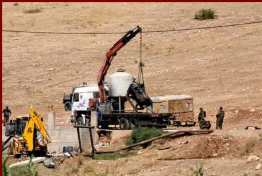
Distruzione di un pozzo acquifero palestinese a Al Nassarya (Hebron) 08.04. 2014
