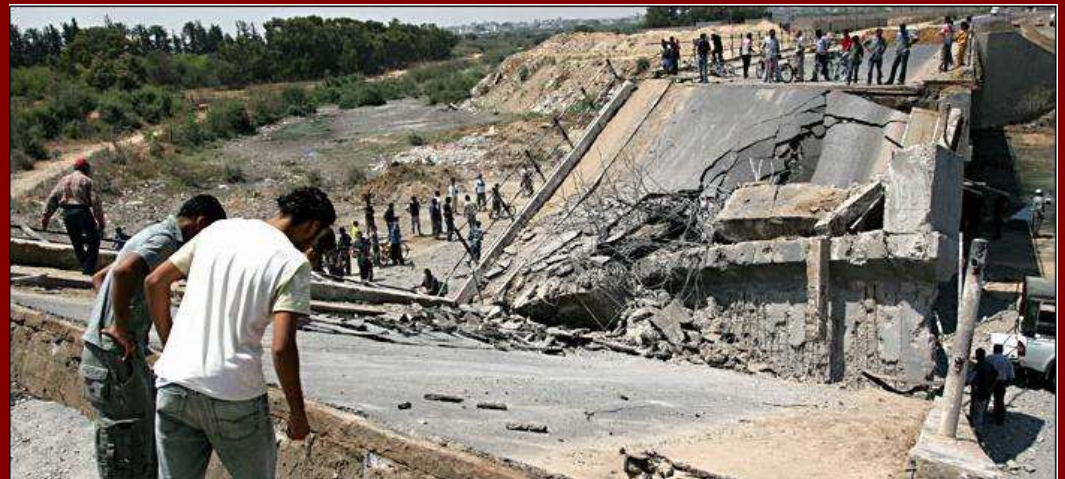
Ponte distrutto a Gaza, 28.06.06
