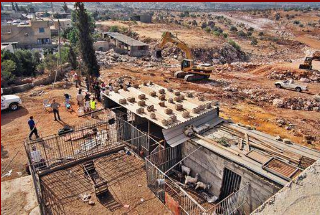
La stalla del sig. Ammer prima della costruzione del muro
