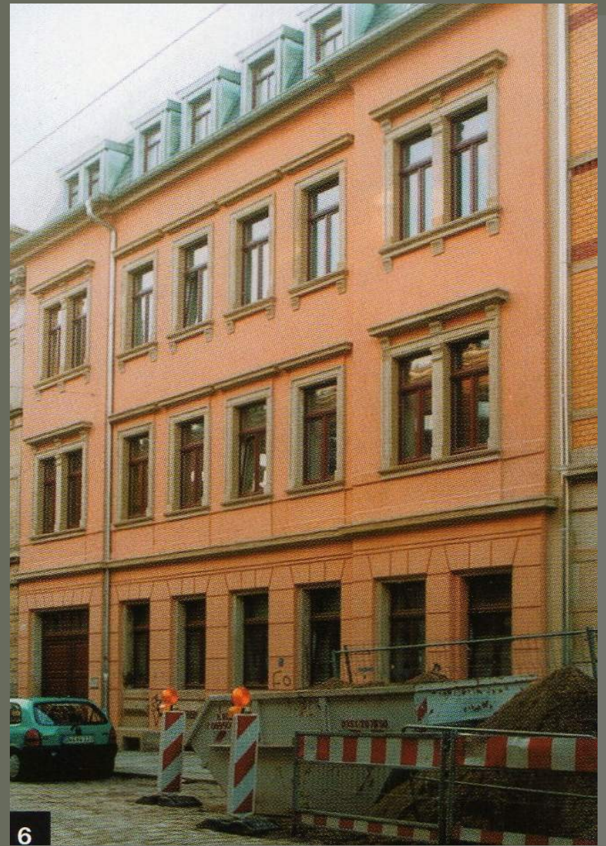
Un esempio di ristrutturazione nella Neustadt.
