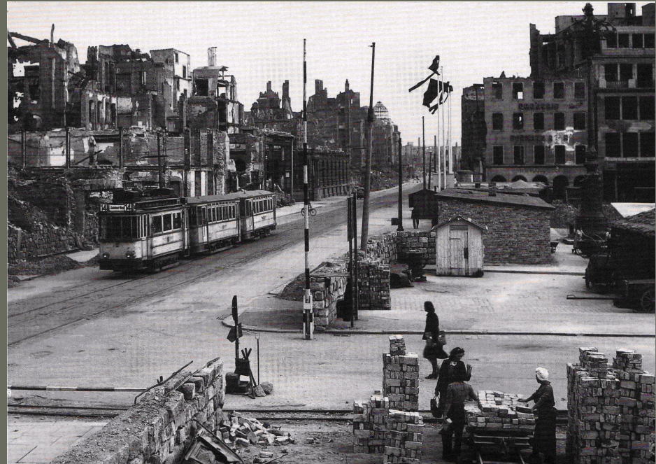
Thalmanstr. dopo i bombardamenti.
